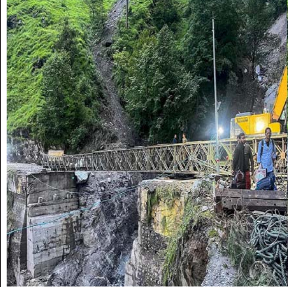
गंगोत्री राष्ट्रीय राजमार्ग पर लिमचागाड के गंगनानी के पास घाटी पुल का निर्माण कार्य चल रहा है।
